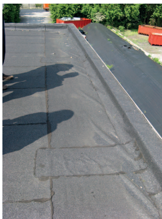
Afb. 57 Rimpelvorming op een dak.
