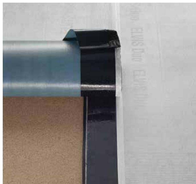
Beispiel: Jumbostar Elvis Duo - als Unterlagsbahn mit Dampfdruckausgleichsschicht direkt auf Holz verlegt.
